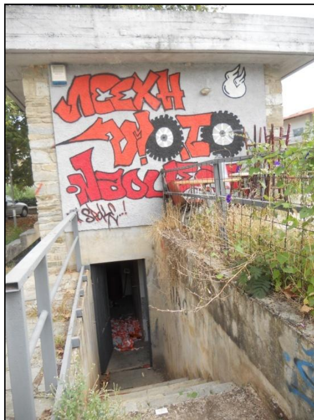
ΕΙΚ. 6 ΥΦΙΣΤΑΜΕΝΟ ΚΤΙΣΜΑ
